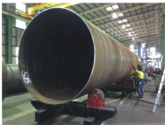
Línea de crecimiento móvil motorizada de 100 toneladas
